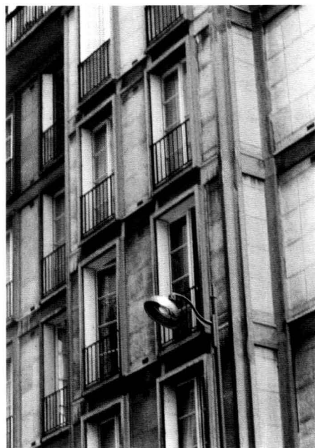
8. 51, rue Raynouard, Paris, 1928–1930, Perret.
